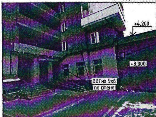
Прокладка кабеля по пристройке
